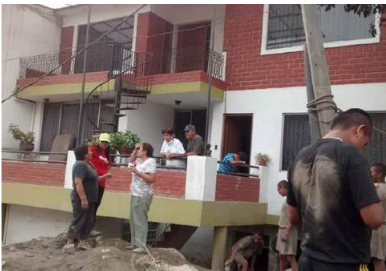
Se puede observar que el grupo de personas está parado sobre el material acumulado, casi al nivel del balcón del segundo piso.
