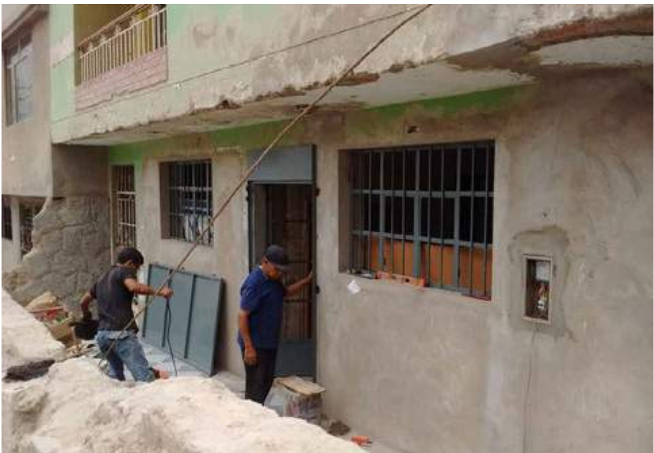
Trabajos de reposición de puertas y ventanas de fierro
