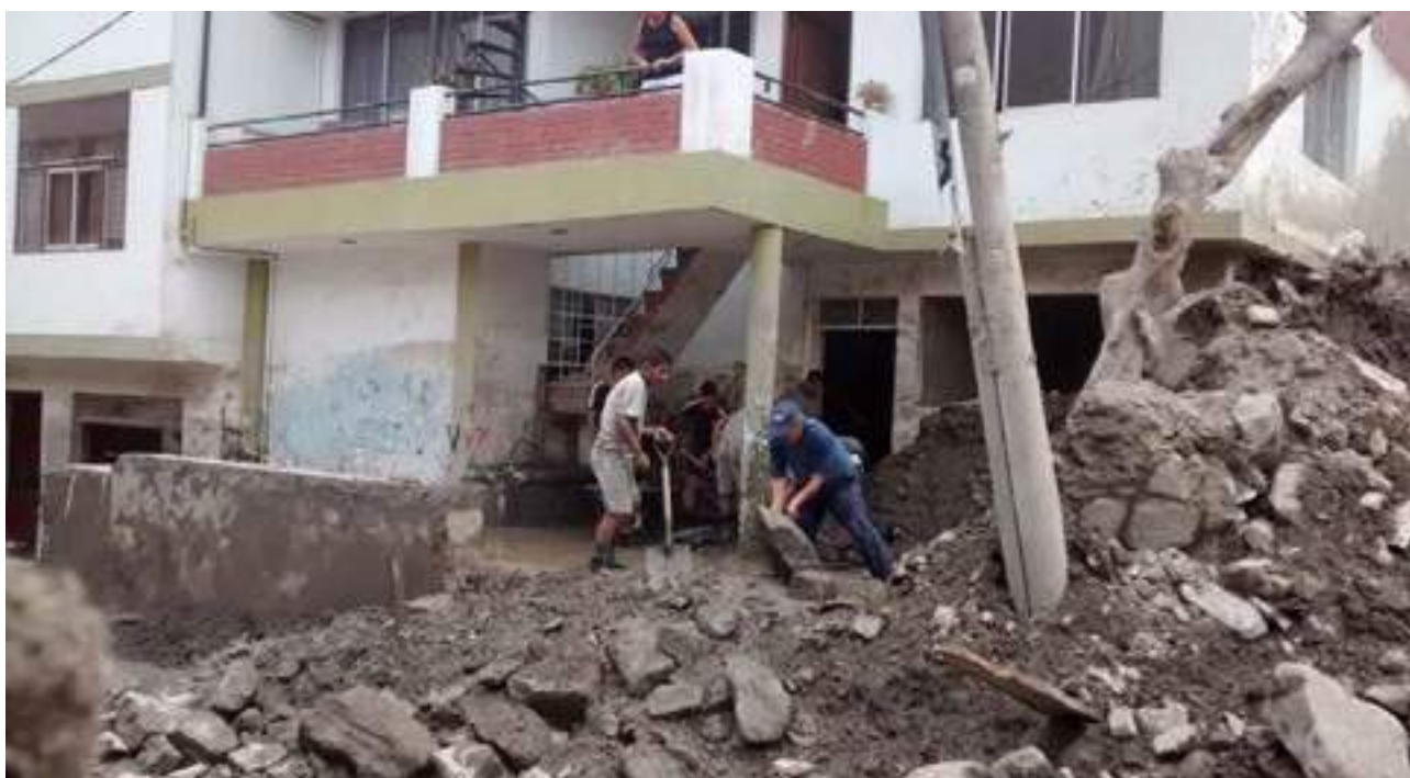
Ingreso al domicilio de la familia Soto Correa, cuyo primer piso fue inundado completamente, por el material del huayco ingresado por las calles Jorge Chávez, Miguel, Grau, y Andrés Avelino Cáceres.
