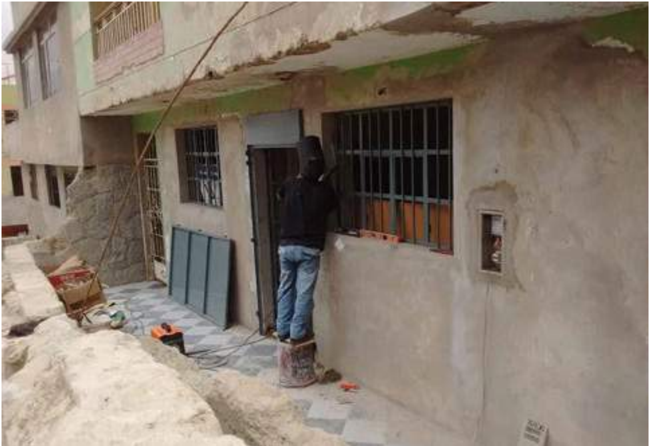
Trabajos de reposición de puertas y ventanas de fierro
