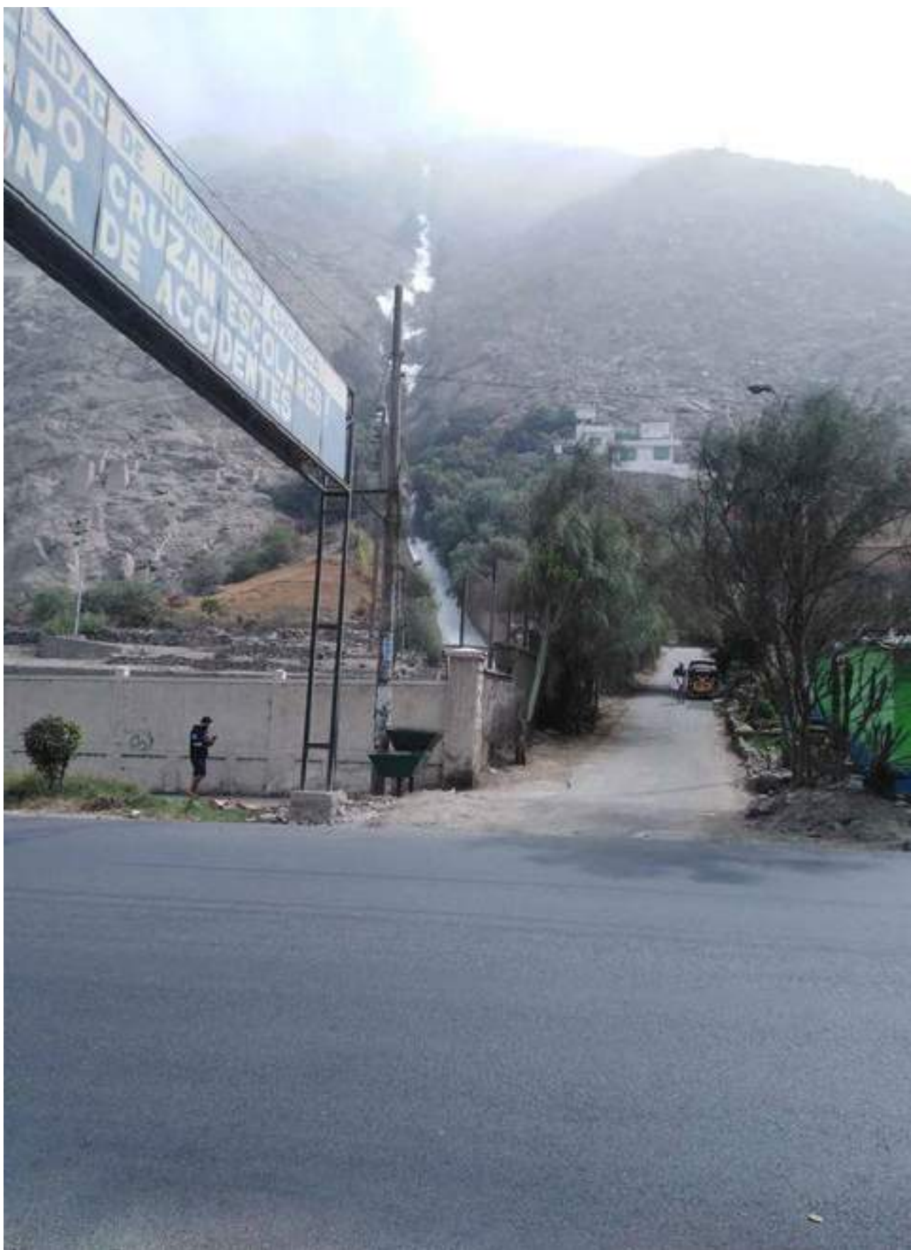
Difícil creerlo, la Central Hidroeléctrica Moyopampa es uno de los complejos energéticos del distrito de Lurigancho-Chosica que más uso hace del recurso agua. Nótese en la presente fotografía a su canal de demasía arrojando agua al lecho del río Rímac.
